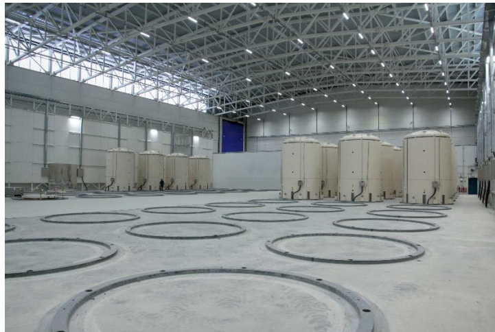
Slika: Suho skladišče izrabljenega goriva v NEK
